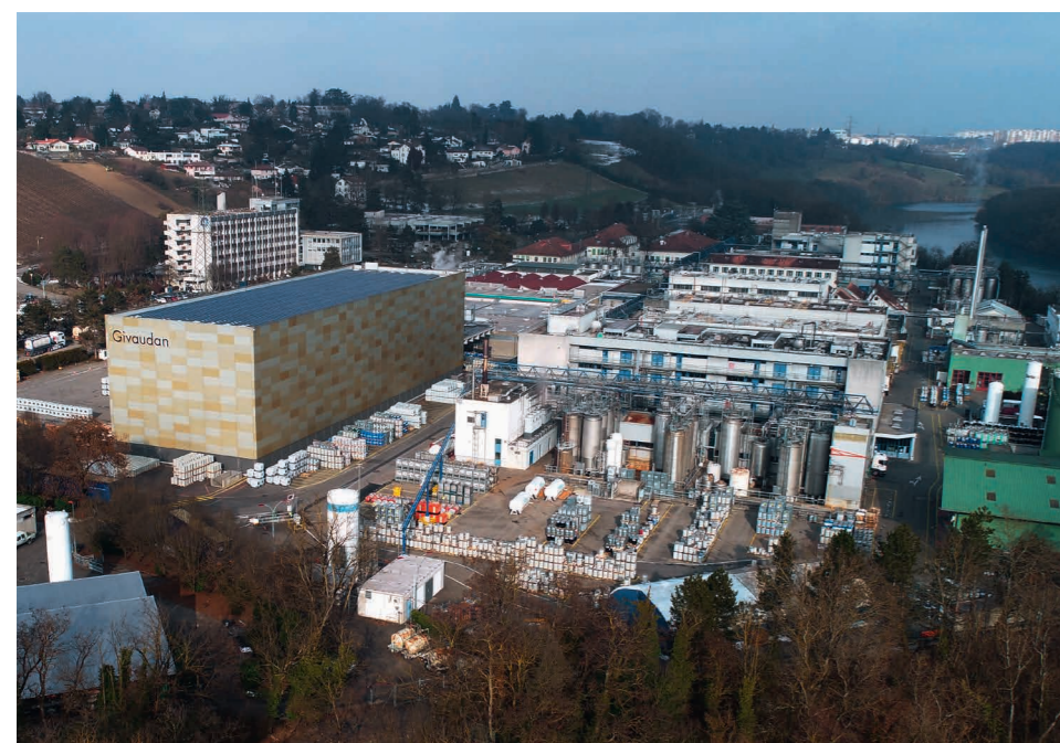
Givaudan Vernier, siège mondial et plus grand site de production de parfums du Groupe, occupe au bord du Rhône la parcelle de la première usine de 1898. (Photo : C. Curdy)
