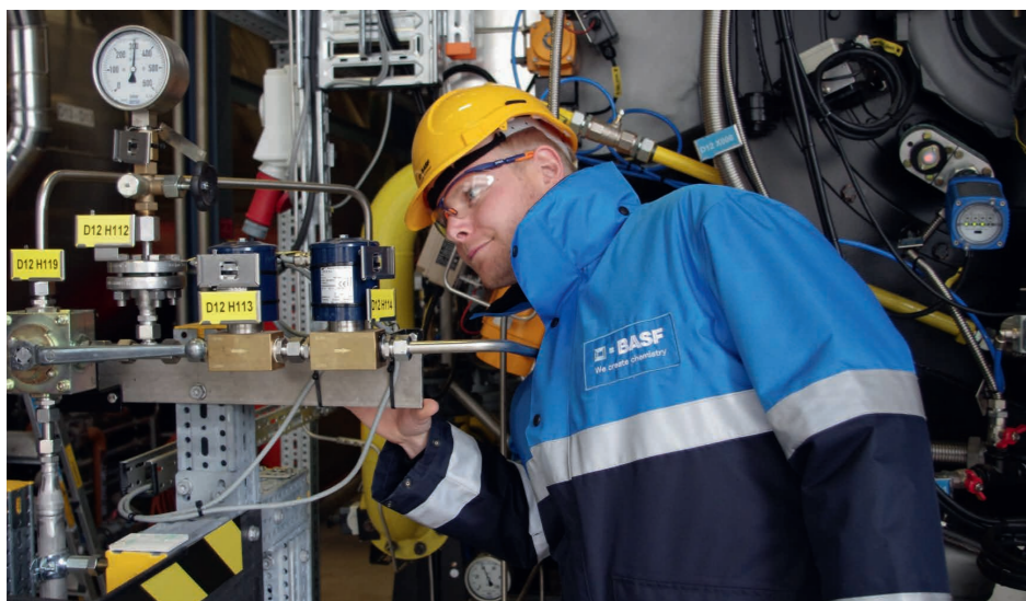
Depuis 2008, BASF Suisse SA ne cesse de mettre en œuvre de nouvelles mesures qui améliorent sa performance énergétique.
